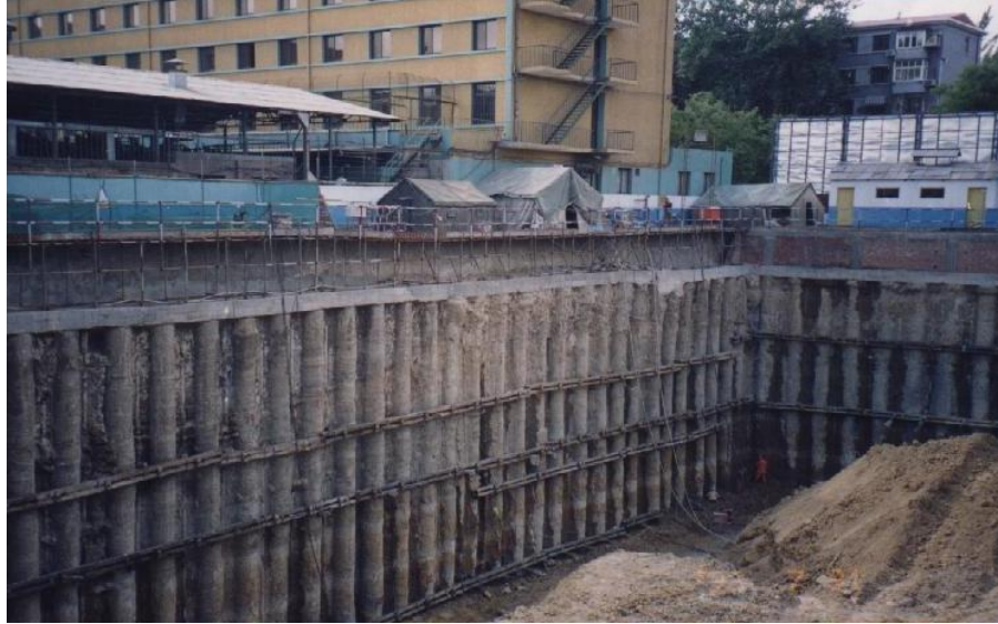
昆仑公寓基坑支护，拉力分散型锚杆的应用。
